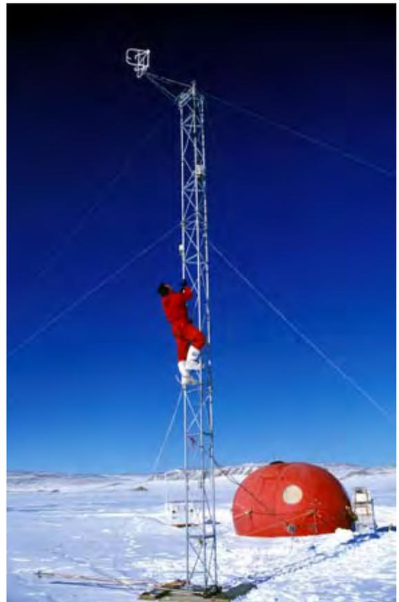
Installazione di un palo attrezzato per la misura della dinamica dei primi metri dello strato limite; Hells Gate, Antartide
