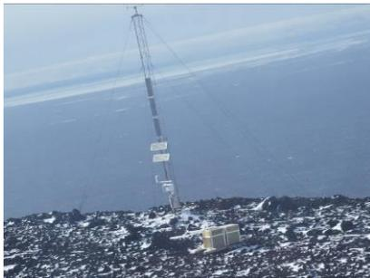
**Stazione Silvia** (Cape Phillips), sono state progettate e realizzate 2 nuove casse per contenere le batterie che permetteranno una più facile e sicura manutenzione delle stesse. In un successivo intervento è stata eseguita la bonifica del sito portando via le vecchie casse ed i materiali di risulta.
