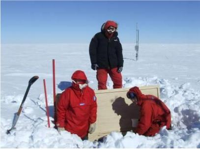
**Stazione Paola e Driftometro** (Talos Dome), entrambe le stazioni sono state rialzate a causa di un forte accumulo di neve, il Driftometro è stato oggetto di un intervento di riparazione al sistema di condizionamento di potenza e alla sostituzione della batteria interna al Litio (CR2430). E' stata effettuata l'ispezione e la manutenzione delle batterie.
