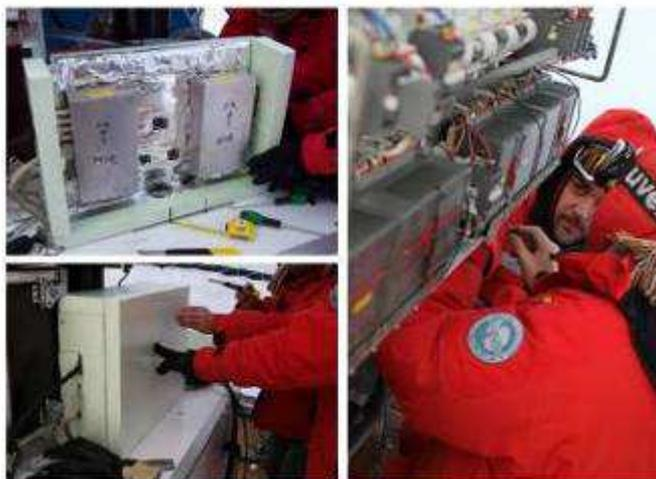
Fig. 4 – L'installazione dei due riscaldatori aggiuntivi da 50 W e delle due sonde di temperatura PT100 all'interno delle scatole elettroniche attaccate al criostato, e di una terza sonda di temperatura PT100 sulla parete laterale esterna del criostato. electronic boxes.
