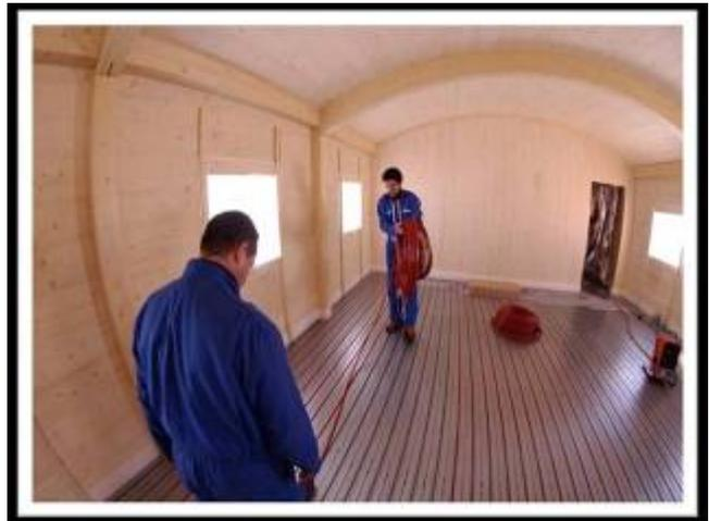
Laboratoire d'Astronomie: finitions extérieures et pose du plancher chauffant
