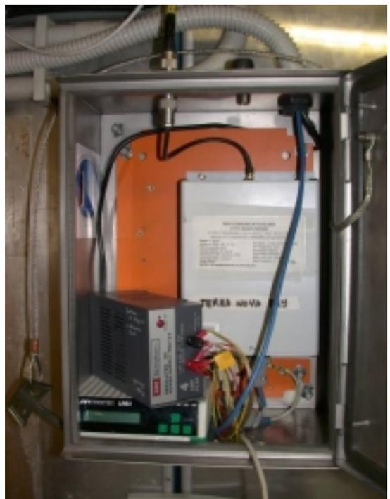
Fig. 1.2.2 - Radio Modem, router Lantronix e alimentatore all'interno del container PAT a MZS
