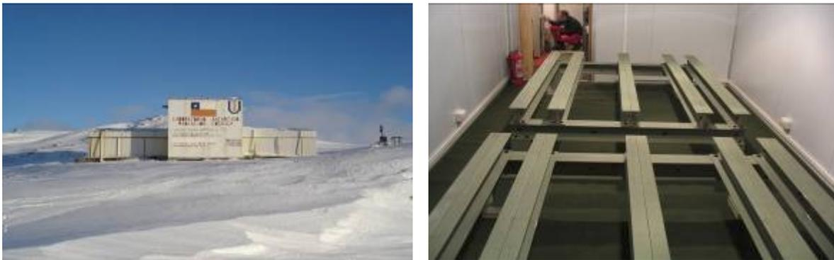
Fig. 7.6.1 – A sinistra una vista frontale dell'osservatorio LARC: il modulo a destra ospiterà la nuova sezione di contatori. A destra è riportata un'immagine della struttura in metallo di supporto ai contatori
