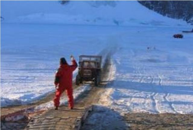
La strada modulare, viene normalmente impiegata come unione tra la terraferma ed il pack. Garantisce la sicurezza dei transiti dei mezzi. E' galleggiante sull'acqua e sopporta il carico dinamico di pesanti macchine operatrici.
