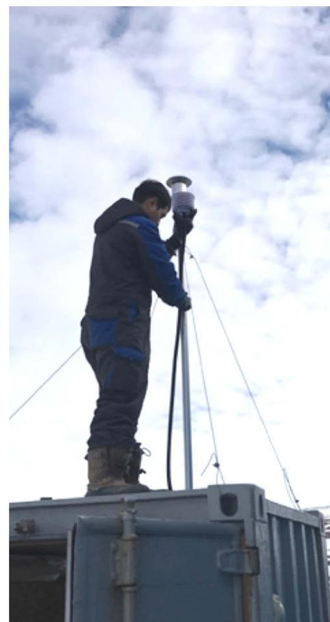
*Prog. 2016/B3.01: Installazione della testa di prelievo*
