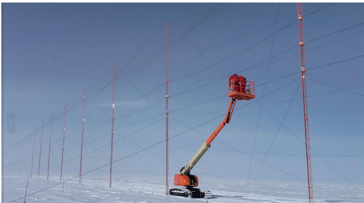
Il SuperDARN – il radar a bassa frequenza installato presso la Stazione Concordia
